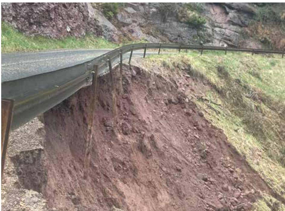
Bei der Verbindungsstraße von Afing nach Flaas kam es zum wiederholten Mal zu Unwetterschäden durch Abbrutschungen.
